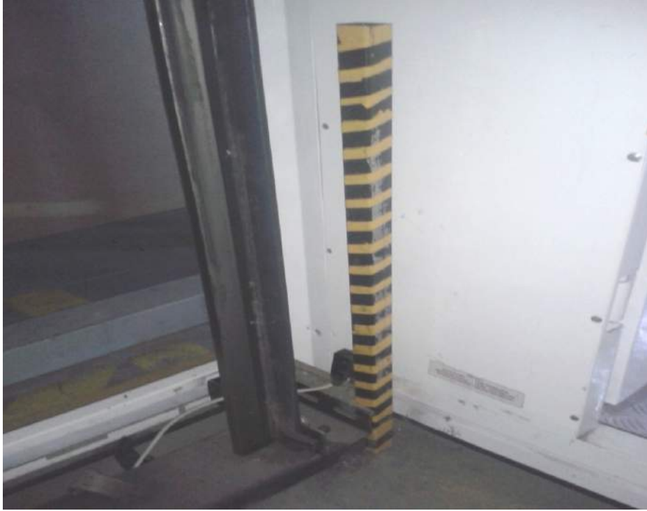
Resim 3. Mekanik durdurucu
