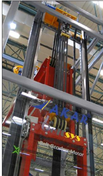
Şekil 6. beltsys® Sisteminde Kullanılan Polyemit Saptırma Kasnağı Montaj Şekli
