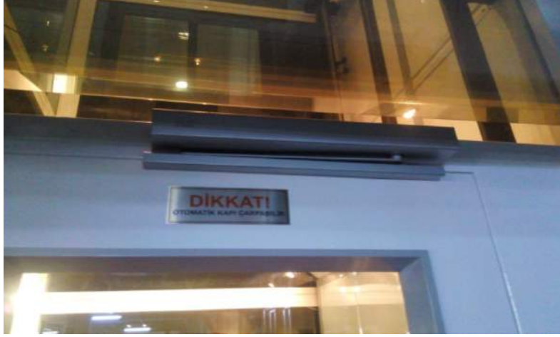
Resim 7. Kapı açma mekanizması
