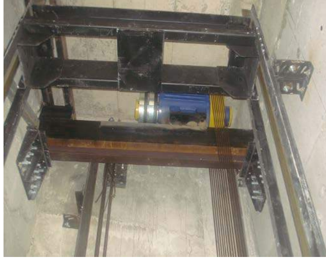
Şekil 2 (Devam) e) Kuyu içi makine dairesiz montaj
